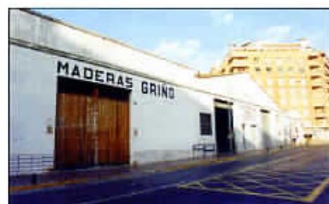
Edificaciones a derribar.
