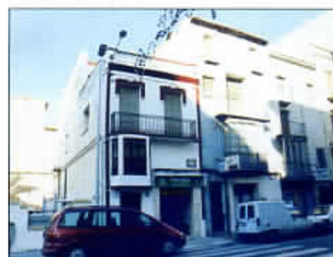
Tres edificios de la calle San Francisco que serán derribados.
