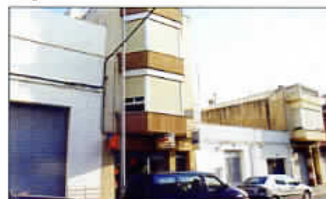
Casas de la calle Virgen, a derribar.
