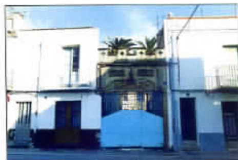
Calle San José, entrada Torre Ballester.
